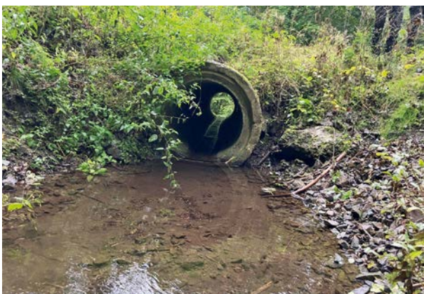
Abbildung 1: frisch gereinigter Durchlass unter einem A-Weg (Foto: Dr. Alexander Kaulen)
