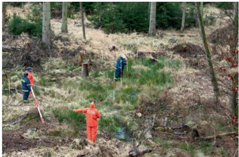
Abb. 1: Einmessen der Bohrlöcher
