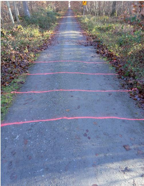
*Beispiel 5: Verformung Deckschicht – Klasse 2*
