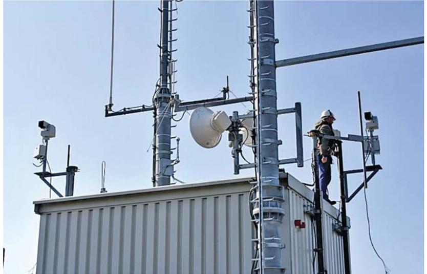
Abb. 5 AWFS-Sensoren (Doppel-Kamerasystem) auf dem Förderturm des Erkundungsbergwerks Gorleben
