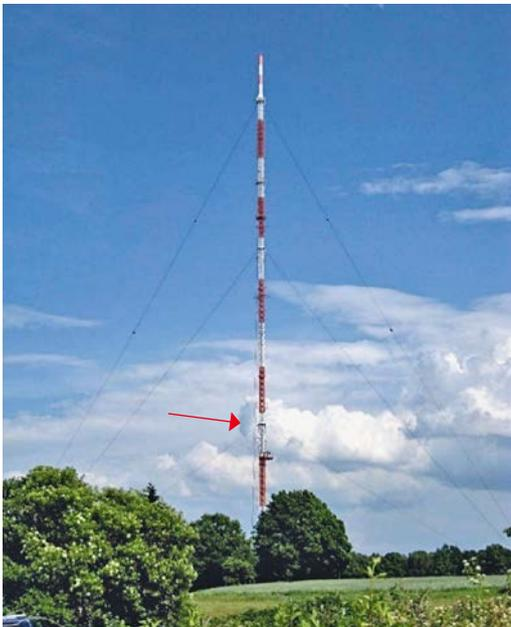
Abb. 6: NDR-Sendemast Zernien. Die beiden AWFS-Sensoren sind über der Plattform am Ansatzpunkt der untersten Pardunen in 80 m Höhe befestigt (Pfeil)
