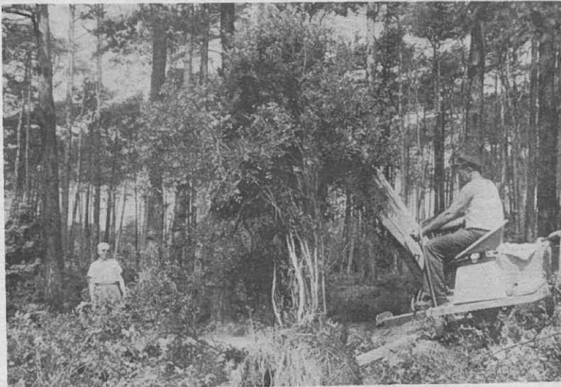
Abb. 13: Reinigung eines Vorflutgrabens mit Poclain-Bagger. Strauchwerk wird ausgehoben und beiseite gelegt (Foto: Fischer)
