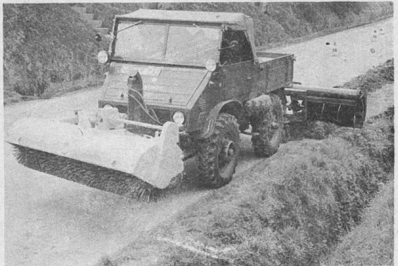
Abb. 4: Räumung des Randstreifens mit Schmidt-Bankettfräse auf Landstr.
