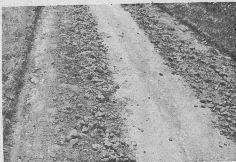
Abb. 23: Ausschnitt aus einer Wegstrecke nach Wiederherstellung des Regelquerschnitts mit dem "Gottwalt'schen Weggerät" in betonhartem Muschelkalk.
