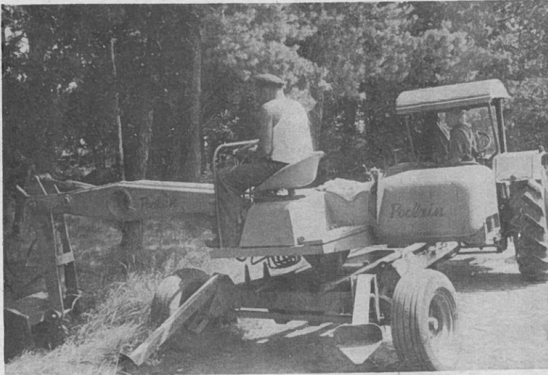
Abb. 11: Poclain-Bagger. Gute Standfestigkeit durch grosse Spurweite und tiefen Schwerpunkt (Foto: Fischer)
