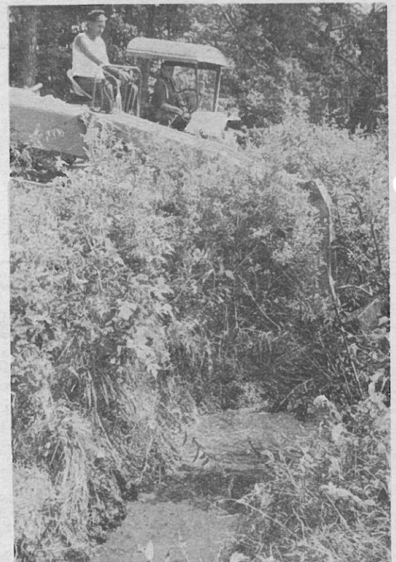
Abb. 13: Reinigung eines Vorflutgrabens mit Poclain-Bagger. Strauchwerk wird ausgehoben und beiseite gelegt (Foto: Fischer)
