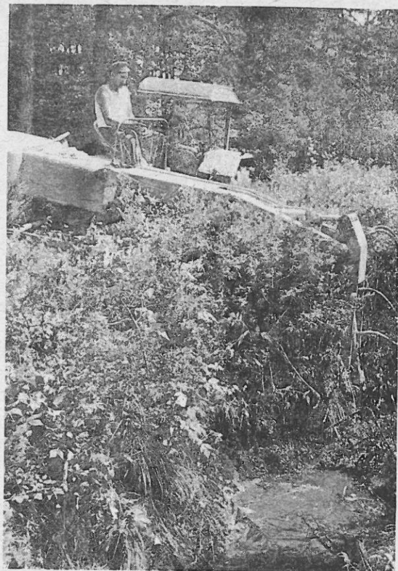
Abb. 17: Bedienung des Poclair-Baggers durch 4 Handhebel (Foto: Fischer)
