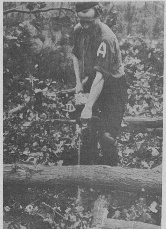
Bild 11: Unter Spannung liegende Stämme werden mitten durchstoßen, nach unten weitergesägt. Zum Schluß wird der obere Teil von unten her durchgesägt
