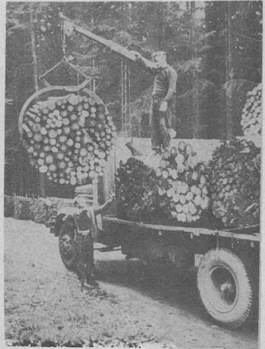
Abb. 8: Verladung der Bündel mit Lkw-montiertem Steinbock-Ladekran mit Bündelzange.
