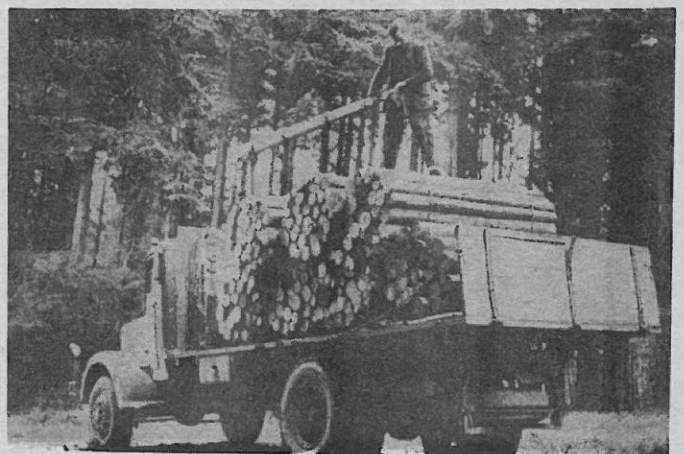
Abb. 6: Wie Abb. 4. Verladen der Bündel mit Lkw-montiertem Steinbock-Ladekran, Einschwenken und Zusammenstecken des Ladekrans vor der Abfahrt.
