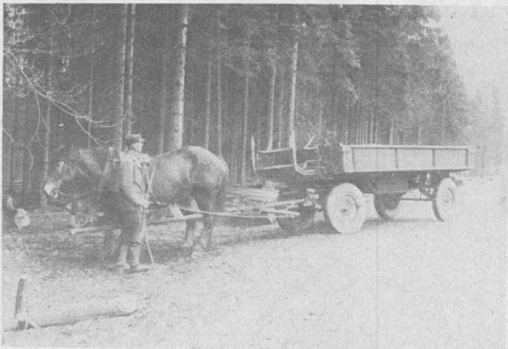
Bild 1: Stahlkippwagen mit 5 to Tragkraft.
