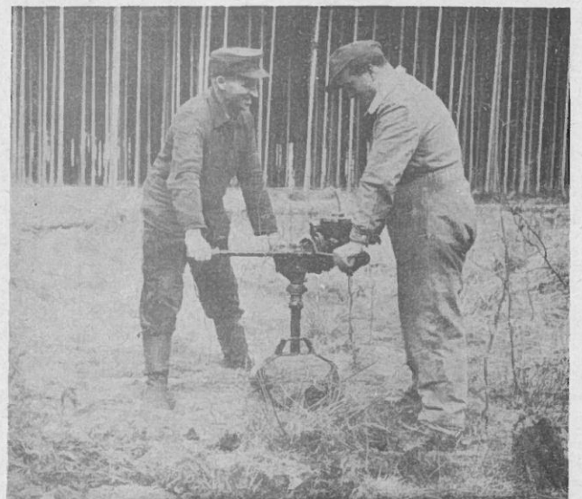
Abb. 7: Stihl-Forstkombination zur BLK mit Rahmenbohrer oder Krümmler.
