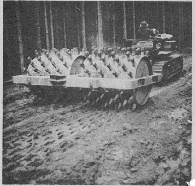
Schaffußwalzen auf schluffhaltigem Lehm
