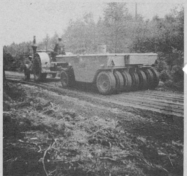
Gummiradwalzen beim Verdichten einer Sand-Bahn-Decke
