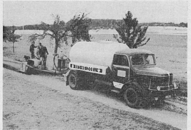
Abb. 5: Mixed-in-place-Verfestigung vor aufgebrachtem, gebrochenem Siebschuttmaterial (Kreis Horb 1960).
