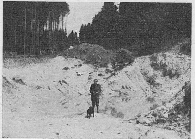
Örtliche Gewinnung der Zuschlagstoffe für den nebenstehenden Weg in Fürstl. Sandgrube Fm. Eckstein, Wächtersbach
