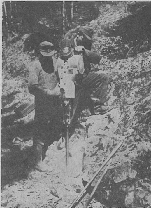
Zweimannbedienung bei größerer Bohrlochtiefe
