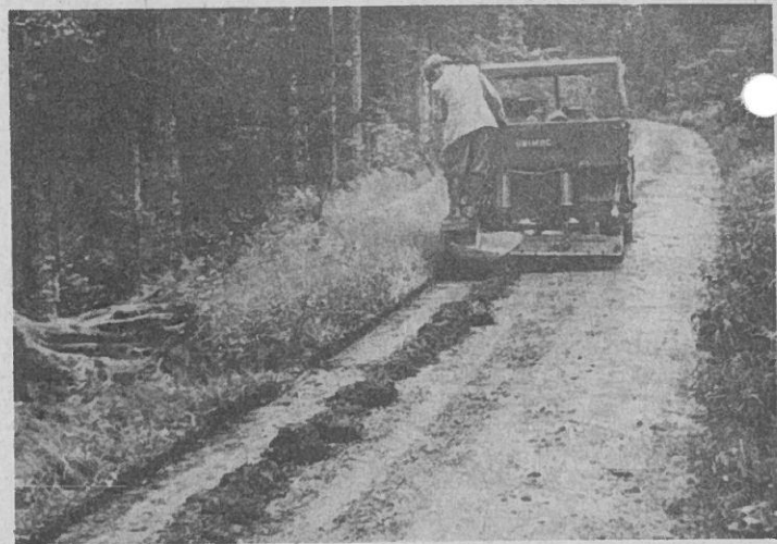
Einsatz des Profiliergerätes mit Bordkantenschneider auf stark vom Bankett her grasbewachsenem Waldweg
