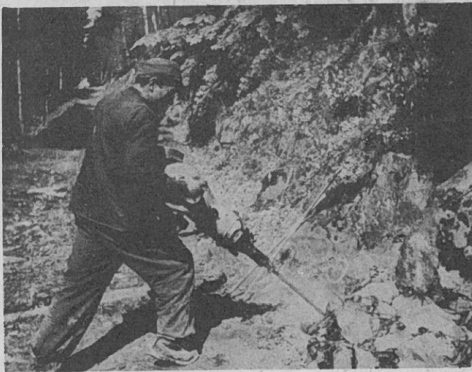
Beim Schrägbohren wird das Gleitblech auf das Knie aufgelegt
