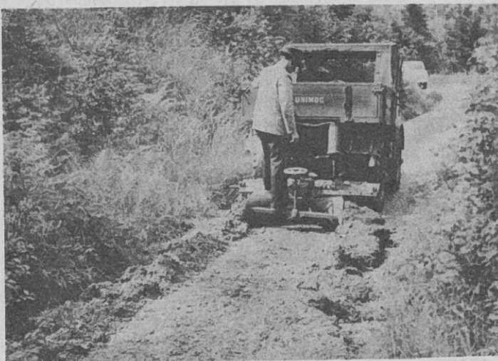
Der Mittelstreifenpflug am Profiliergerät entfernt den sogenannten "Schweinsrücken" Mitte Fahrbahn
