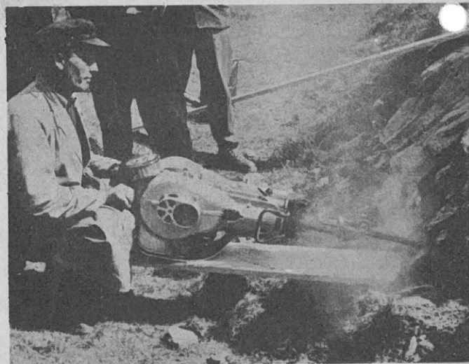
Beim waagerechten Bohren empfiehlt sich die Schaffung einer stützen- den Auflage
