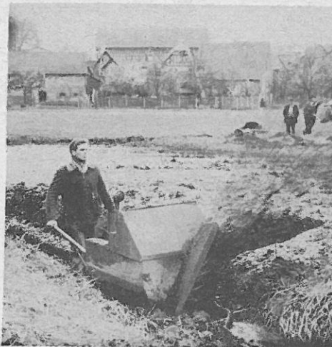
Sohlräumgerät "Grabenfrei" mit Schleudervorrichtung.
