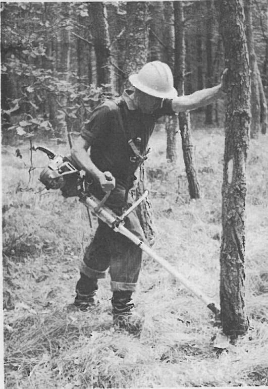
Abb. 3: Der Fällschnitt
