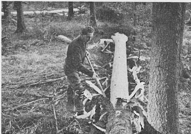
Abbildung 2: Schlechte Arbeitsstellung: Arbeit mit zu stark abgewinkeltem Eisen.
