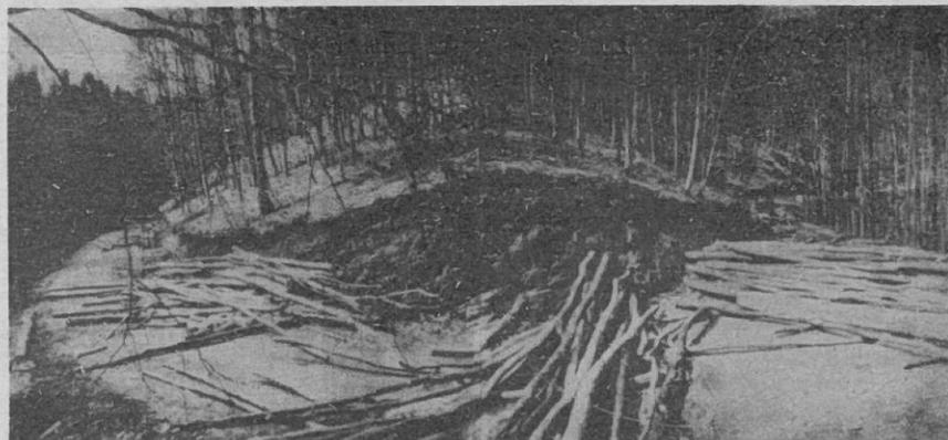
Hangaufschluß im Forstamt Merenberg bei Weilburg. Die Windenaufstellung auf einer Bergnase erlaubt dem Windenführer gute Sicht nach 3 Seiten. Mit der Aufstellung wird eine große Fläche erschlossen.
