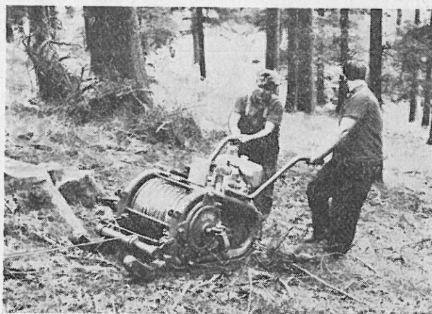
Abb. 5: Abseilwinde Heros „Seilbub“ beim Instellbringen
