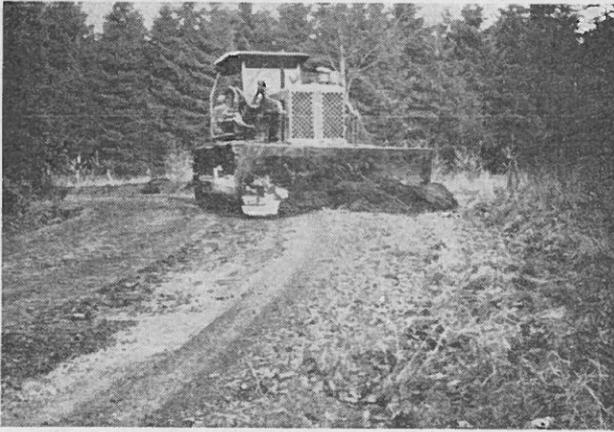
*Beseitigung von Schlaglöchern und Längsrillen auf natürlich festen oder Schüttwegen durch Profilierung mittels einer schweren Raupe (ruhigere Lage, ergibt besseres Längsprofil). Die Kosten betragen 5-7 Dpf./lfdm. Der Einsatz eines Graders ergibt noch besseres Längsprofil, erfordert aber breiteren Wegeauftrieb.*
