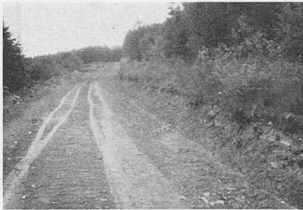
*Nasse Senken und Verebungen erfordern dagegen Trag- und oft auch Deckschichten sowie die Anlage hangseitiger Gräben. Geländeausformung, Standortkartierung und Flora lassen solchen Baugrund stets erkennen, oft kann er dann umgangen werden. Immer werden die weiteren Kosten geringer, wenn sich das Rohplanum — bei absoluter Sperrung für den Verkehr — zunächst absetzen kann.*
