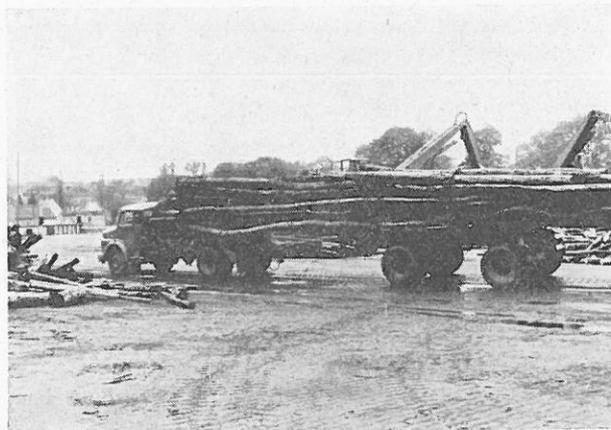
Abb. 4: Ein mit sog. fallenden Längen beladener üblicher Langholz-Lkw kommt im Werk an. Das Verladen erfolgte mit Doppeltrummelseilwinden. Zukünftig kommt hier vermehrt der Hydraulikkran zum Einsatz. Für das Entladen werden nur wenige Minuten benötigt. Mit einem Schaufellader werden nach dem Öffnen der Rungen die Hölzer heruntergeschoben. Die Ladekapazität der Fahrzeuge kann in jedem Fall voll ausgenutzt werden. Sorgen bereitet eher das allzu häufige Überladen.
