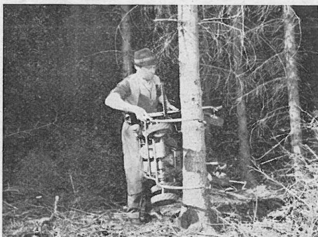
Abb. 5: Ansetzen des Gerätes zur Aufastung einer Fichte. Der im Bild geöffnete Tragrahmen des Geräts wird anschließend durch zwei Federzüge geschlossen.
