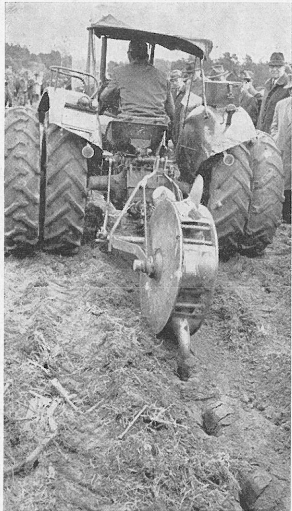
Abb. Pflanzlochgerät nach Oberförster Zacharias im Forstverband Salzhausen (foto Jahn)
