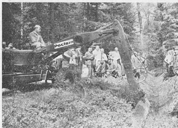
Abb. Poclair-Anhängebagger TO beim Grabenräumen (Exkursion Medingen; foto Jahn)
