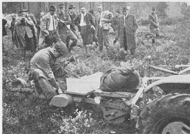
Abb. Dänische TOLNE-Pflanzmaschine, auch für durchwurzelten Boden (Exkursion Lüß; foto Jahn)
