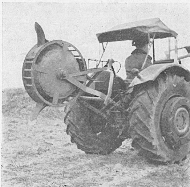
Abb. 7: Pflanzlochgerät mit Werkzeugen zur Herstellung von Pflanzlöchern (Gebrauchsmusterschutz und Patent angemeldet).
