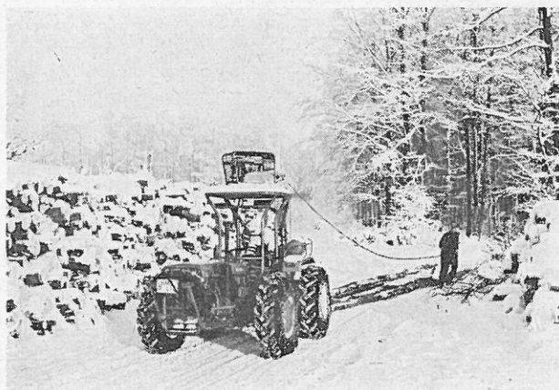
Abb. 3: Zusammenziehen einer Last mit der funkferngesteuerten Winde. Ausziehen des Windenseiles.
