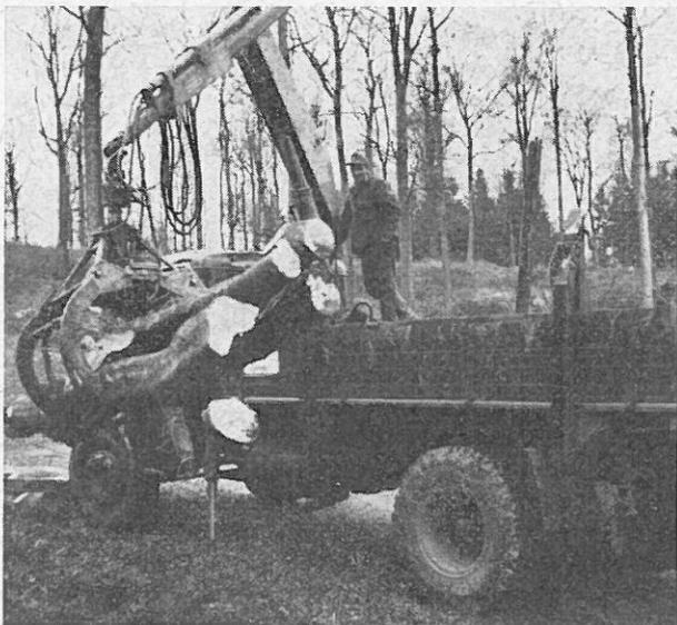
Abb. 7: . . . wird durch gefährliche Kranarbeit ersetzt. Der Bedienungsmann (verdeckt) und die Hilfskraft sind gefährdet (Einmannarbeit wäre schon möglich!)
