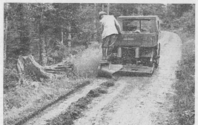
Abb. 4: Der Bordkantenschneider nach Ing. Schmidt. Die Bordkante wird besser herausgearbeitet, wenn ein Mann der Wegebaurotte das Gerät belastet.
