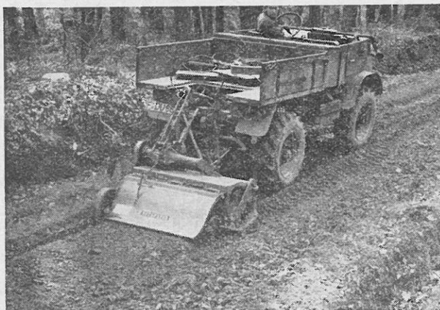
Abb. 6: Die Rotavatorfräse, die auch als Kulturfäse benutzt wird, ist beim Wegebau mit besonderen Steinschlagmessern ausgestattet.
