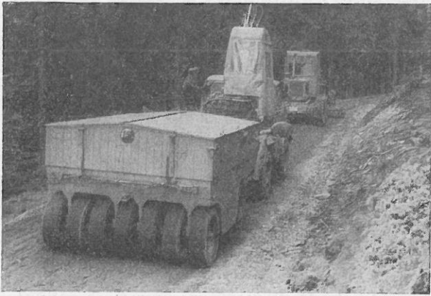
Abb. 4: Cat-Motorgrader (100 PS) mit nachfolgender Gummiradwalze, gezogen von einem Unimog 406 (65 PS). (fot. Reinecke)
