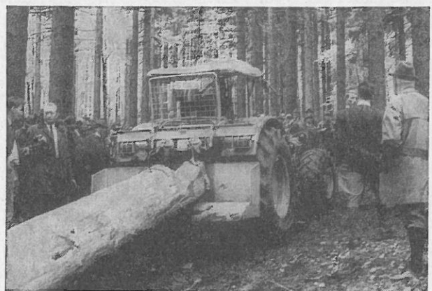
Abb. 2: Schlüter-Schlepper Super 850 V (85 PS) mit Adler-Doppeltrommelwinde und Hebesporn (fot. Reinecke)
