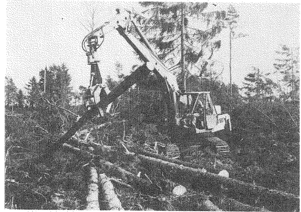
Abb. 2: Entzerren mit Bagger im Längsverfahren fot. Heil
