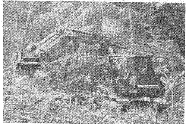
Abb. 5: O & K-Raupenbagger mit OSA-Fällkopf
