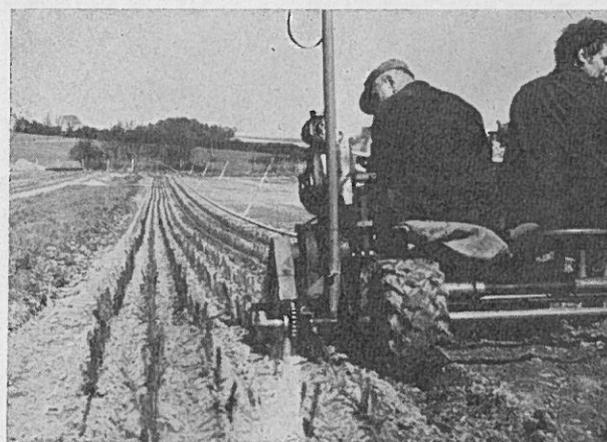
Abb. 2: Verschulmaschine „Hari“ (Selbstfahrer), 2-zeilig ausgelegt.
