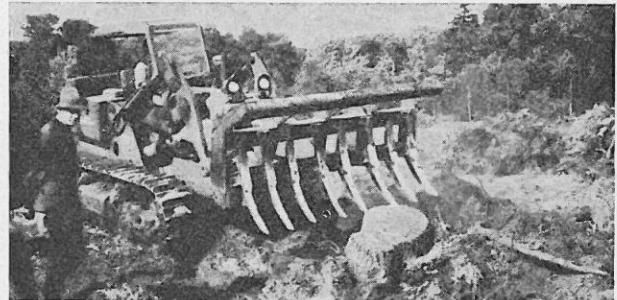
Abb. 1: Raupe mit Roderechen, die auch zum Reiszuzusammenschieben eingesetzt werden kann.
