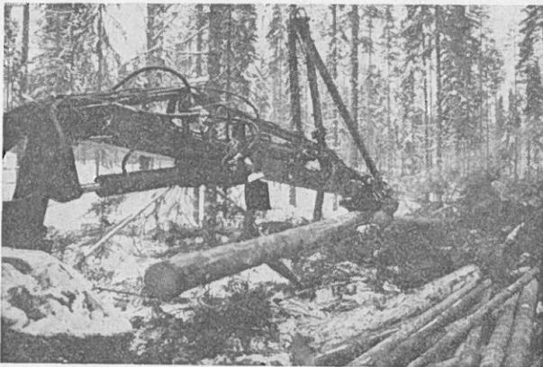
Abb. 2: Auslegearm mit Ablängvorrichtung
