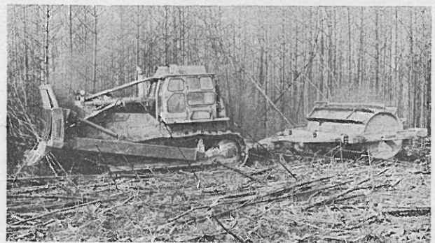
Abb. 7: Zerkleinern nicht aufarbeitungswürdiger Bestände mit einer Hackwalze, gezogen von 200 kW-Planieraupe
