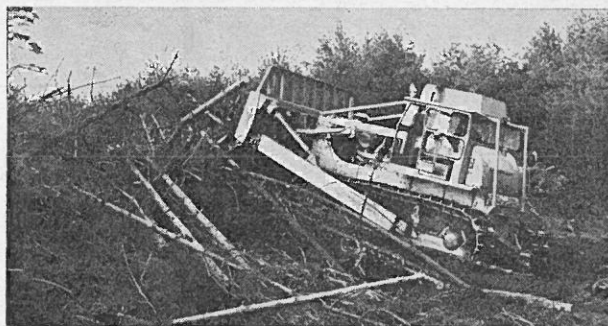
Abb. 2: Abschieben durch Planierdrape mit Spezialwurzelrechen
