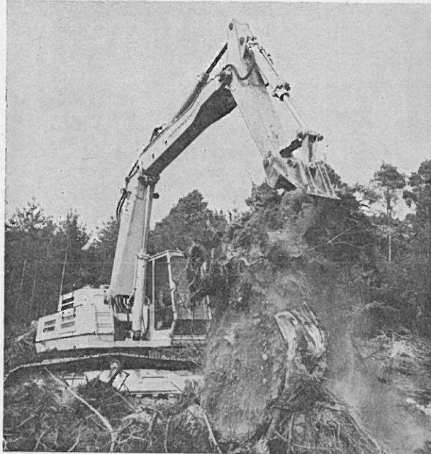
Abb. 1: Roden der Stöcke mit Bagger (70 kW, Spezialrodezahn)
