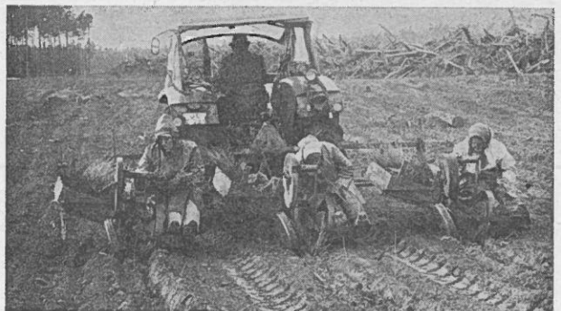
Abb. 8: Maschinelle Pflanzung mit dreireihiger Pflanzmaschine Akkord, Typ Göhrde
