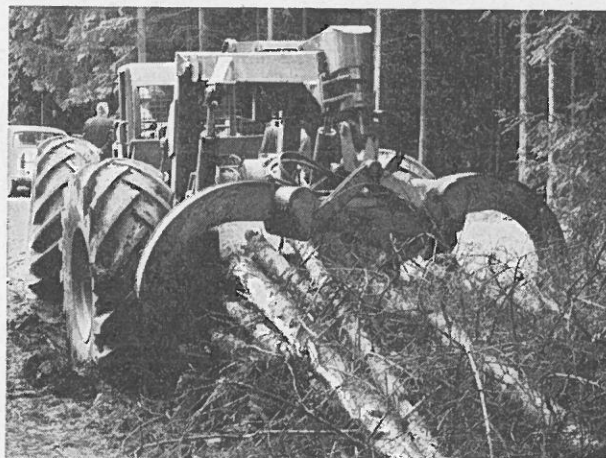
Abb. 1: Timberjack mit Zange beim Rücken von Ganzbäumen
