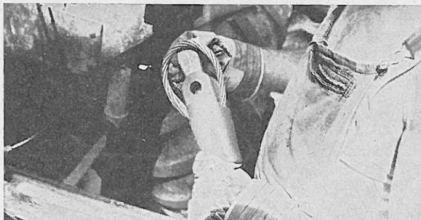
Abb. 9: Das Zugseil wird am Ende mit einem Keilschloß versehen.
