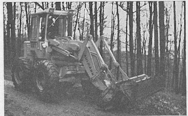
Abb. 4: Grader-ähnliches Abschälen des talseitigen Seitenstreifens mittels aufgeklappter Mehrzweckschaufel am Ahlmann-Schwenklader AS 7 (Foto Waldschmidt)
