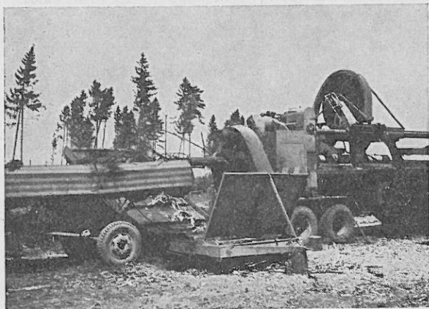
Abb. 7: Gesamtanlage — Ast- und Rindenbeseitigung durch Förderband
