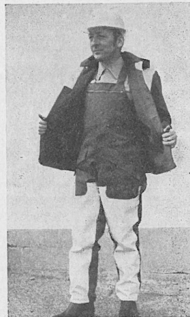
Abb. 1: Schutzkleidung Zweiteiliger Kombinationsanzug in Sicherheitsausführung, bestehend aus Jacke und Latzhose, Machart vgl. 1.3 (Fot. Ziegler)
