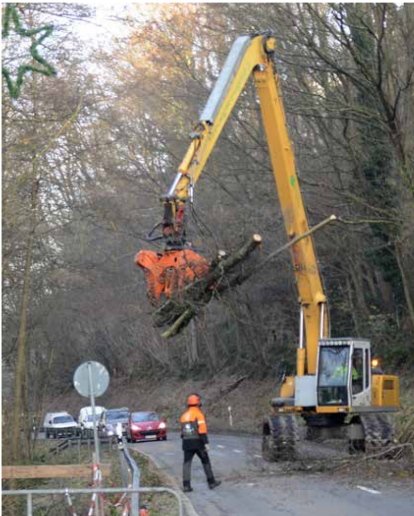
Rückzug und Langstielbagger bei Verkehrssicherungshieb im südlichen Odenwald
