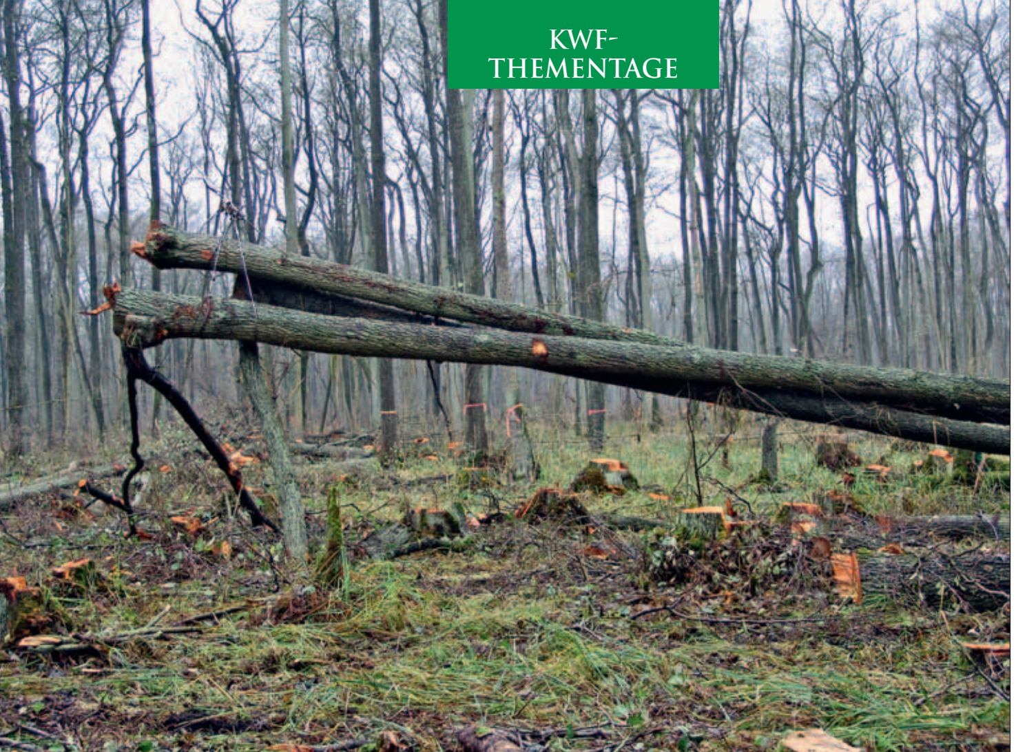
Abb. 2 (Foto: J. Schröder): Auf nicht befahrbarem Moorstandort eingeschlagene Erlen im Endinger Bruch (Forstamt Schuenhagen), die als Rohschäfte halbschwebend aus dem Bestand geseilt werden (Technik: Valentini Langstreckenseilkran V1000 mit Dreiseilsystem).
