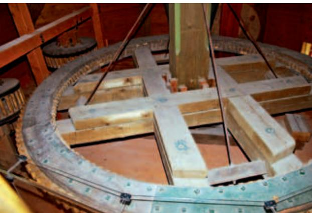
Abb. 8: Antriebszahnrad von 2 Mahlängen am Hauptantriebsrad einer Holländer Windmühle im Hessenpark; 1 Antrieb ausgehängt.
