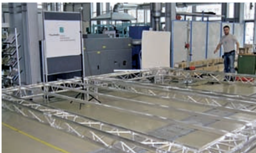
Das Gate wird zusammengebaut (Bild: IFF, Magdeburg)
