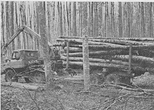
Abb. 1: Rückezug, bestehend aus UNIMOG mit hydraulischem Ladekran und Pendelachsanhänger beim Rücken von Buchen-Industrieholz in Kranlängen auf Rückegasse. (Foto Grammel) (zu Seite 96)
