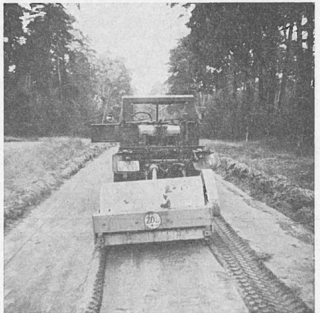
Abb. 5: Festdrücken des Planums mit der Vibrationswalze
