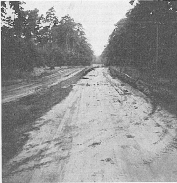
Abb. 6: Billiger Wegebau mit Schwarzwaldgerät und Vibrationswalze. Fertiges Planum abgewölbt und gewalzt auf sandigem Hauptabfuhrweg
