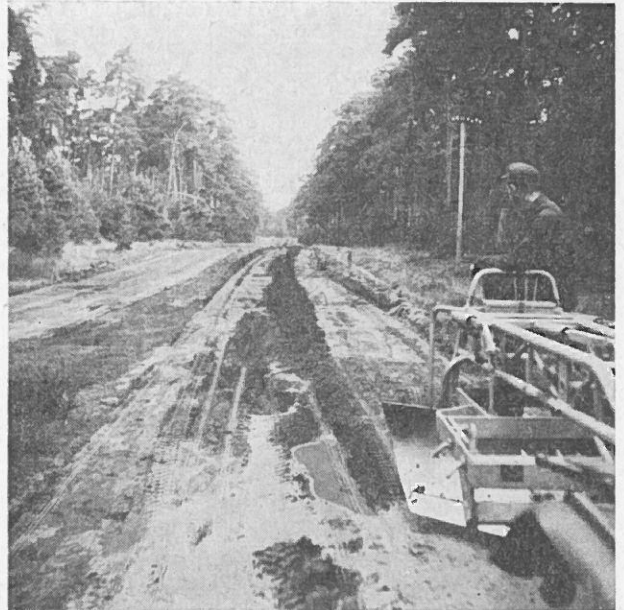
Abb. 4: Das Schwarzwaldgerät bei der Abwölbung d. Planums
