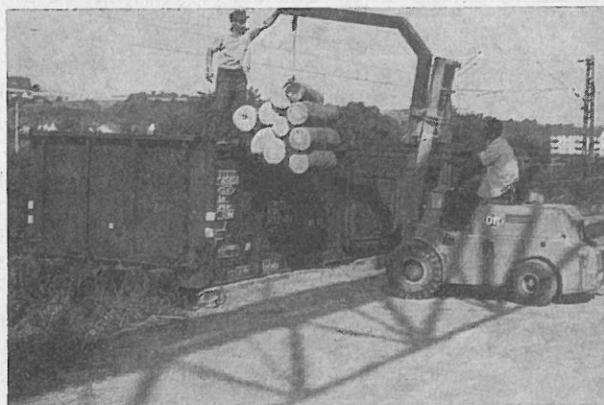
Abb. 3: Transport, Verladung des am zentralen Bearbeitungsplatz eingeschnittenen Buchenschichtholzes mittels Gabelstapler. Spaltarbeit entfällt weitgehend.
