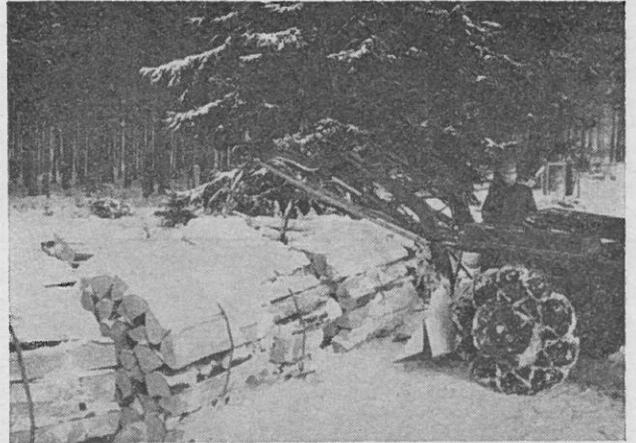
Abb. 9: Nach Absetzen des Bündels am Lagerplatz wird die Zange geöffnet. Man sieht die Bergstütze, mit der das Bündel an den vorgesehenen Platz gerückt worden ist.
