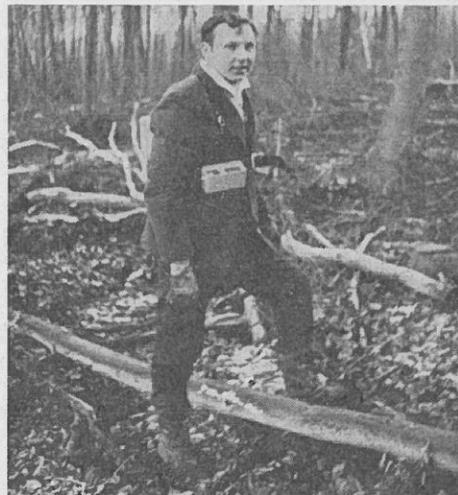
Abb. 2: Rückentragbares Sendergerät mit den beiden am Gürtel befestigten Bedienungselementen.
