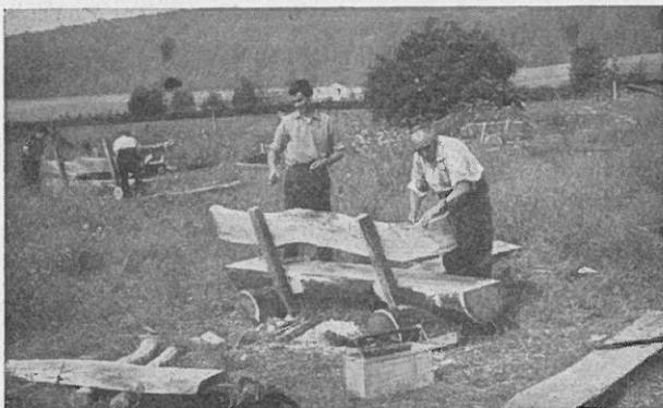
Abb. 1: Rusticale Bank; Sitzfläche aus vom Sägewerk aufgetrennten Eichen-Halbschalen, Eichen-Bohlen als Lehne, 2,5 m lang, Sitzhöhe 40 cm, Lehneneigungswinkel etwa 10 Grad; die Bänke sind sehr schwer, für entsprechende Fahrzeuge aber gut transportabel. Wenn die Unterlagen nach hinten weiter überstehen, können Befestigungspflöcke in den Boden geschlagen und dort zur Sicherung angenagelt werden.
