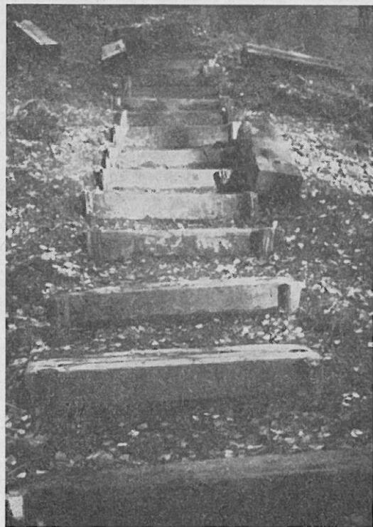
Abb. 12: Treppe mit Stufen von ausgedienten Schwellen.
