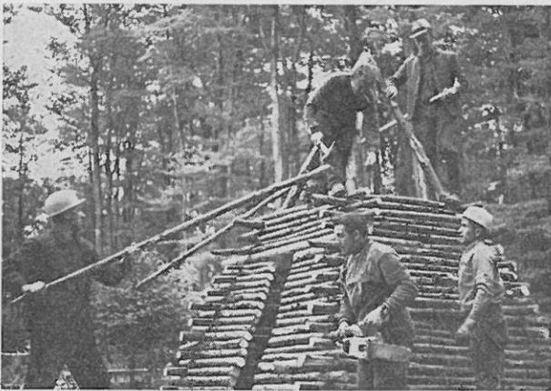
Abb. 9: Die Stangen werden an den Ecken abwechselnd übereinander gelegt, so daß Einkerbungen entfallen können. Vier Arbeitskräfte (hier zusätzl. eine Lehrkraft) können an diesem Indianerzelt besonders rationell arbeiten.
