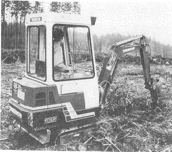
Abb. 1: Einsatz des kleinsten Typs (TB 15) zum Graben der Pflanzlöcher. Im Hintergrund ein Wall aus Stöcken und Schlagmaßraum.
