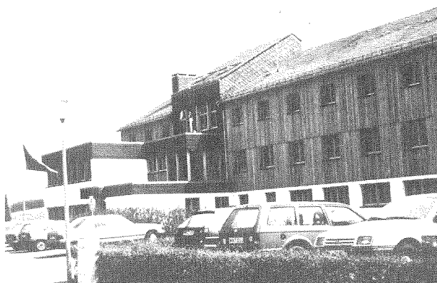
Abb. 1: Frontansicht mit Erweiterungsbau (links), oben neuer Lehrsaaal, unten neuer Speiseraum und neuer Eingangsbereich.
