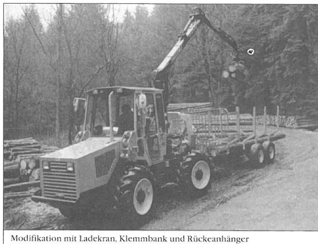
Modifikation mit Ladekran, Klemmbank und Rückeanhänger
